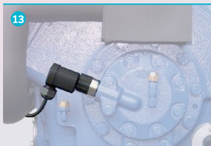
Öldifferenzdrucksensor
